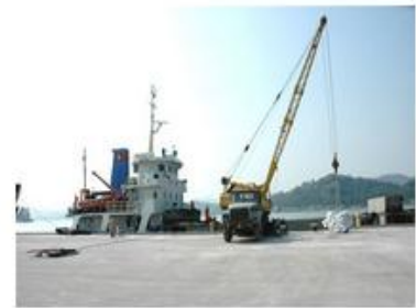
Xây dựng và sửa chữa công trình cảng
